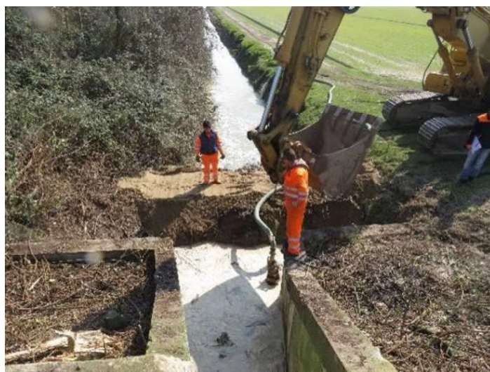
Figura 27. Fase di sostituzione di una chiavica
