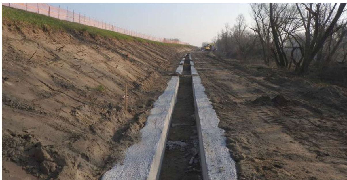
Figura 30. Esempio di diaframma realizzato
