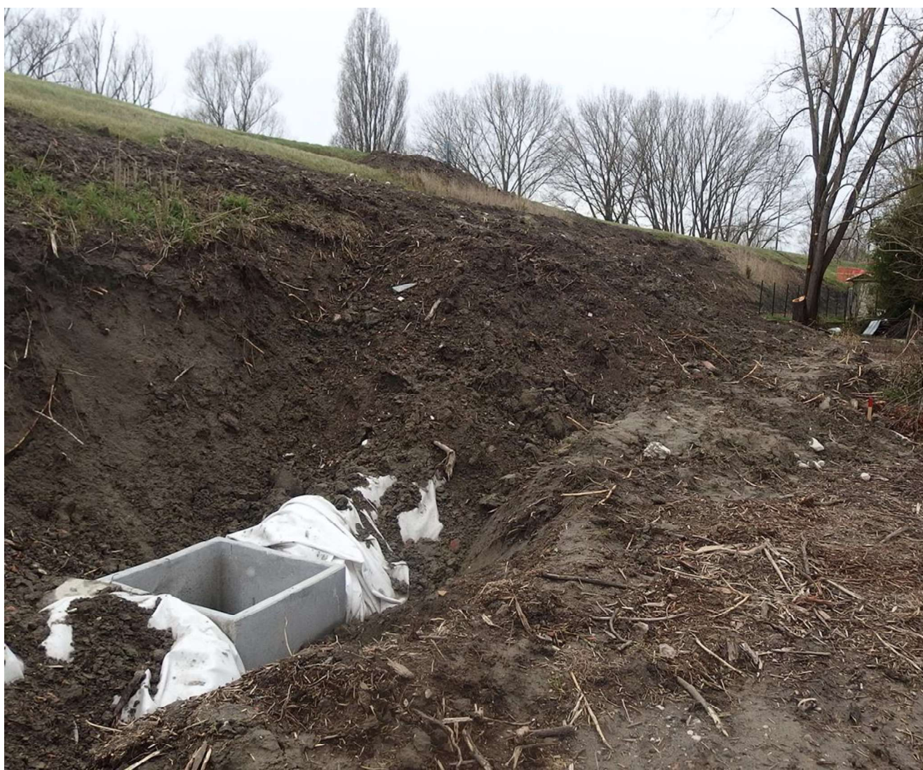
Figura 32. Fasi di installazione di un drenaggio (lato campagna)
